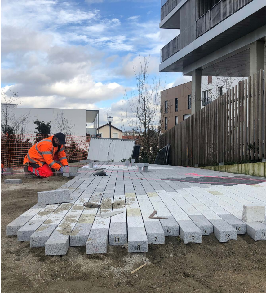
Mise en oeuvre, Mars 2019 - Octobre 2021
